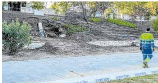
Los operarios trabajando en la avería. PAKOPI
